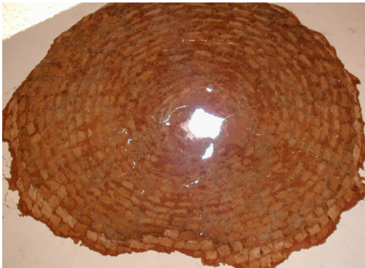
81. Interno di una cupola danneggiata.
