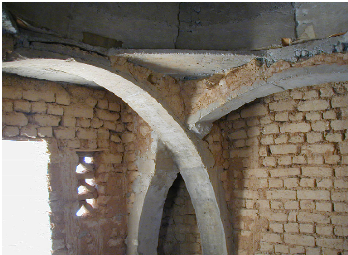
76. Archi incrociati, al grezzo. L'incrocio perfettamente geometrico degli archi sarebbe stato costruttivamente molto impegnativo. La soluzione è con un arco che si interrompe sull'incrocio.
