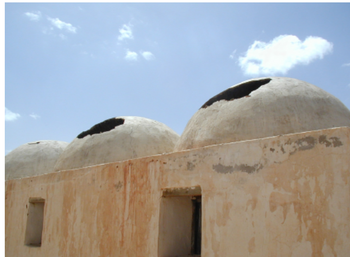
82. La scarsa impermeabilizzazione e la sottostante sigillatura in terra hanno provocato il distacco dei mattoni in adobe causando danni irreparabili alle cupole dei villaggi.
