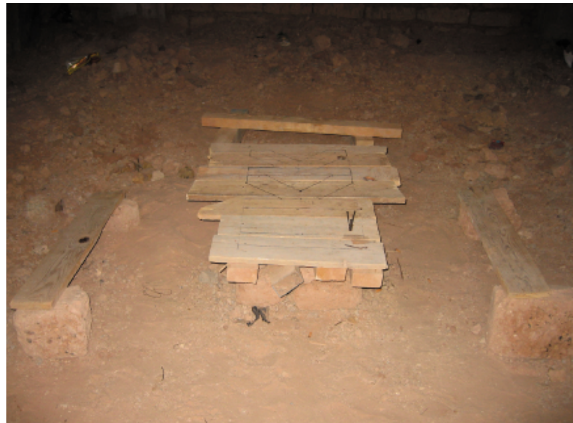
80. Il tavolo di lavoro in cantiere.
