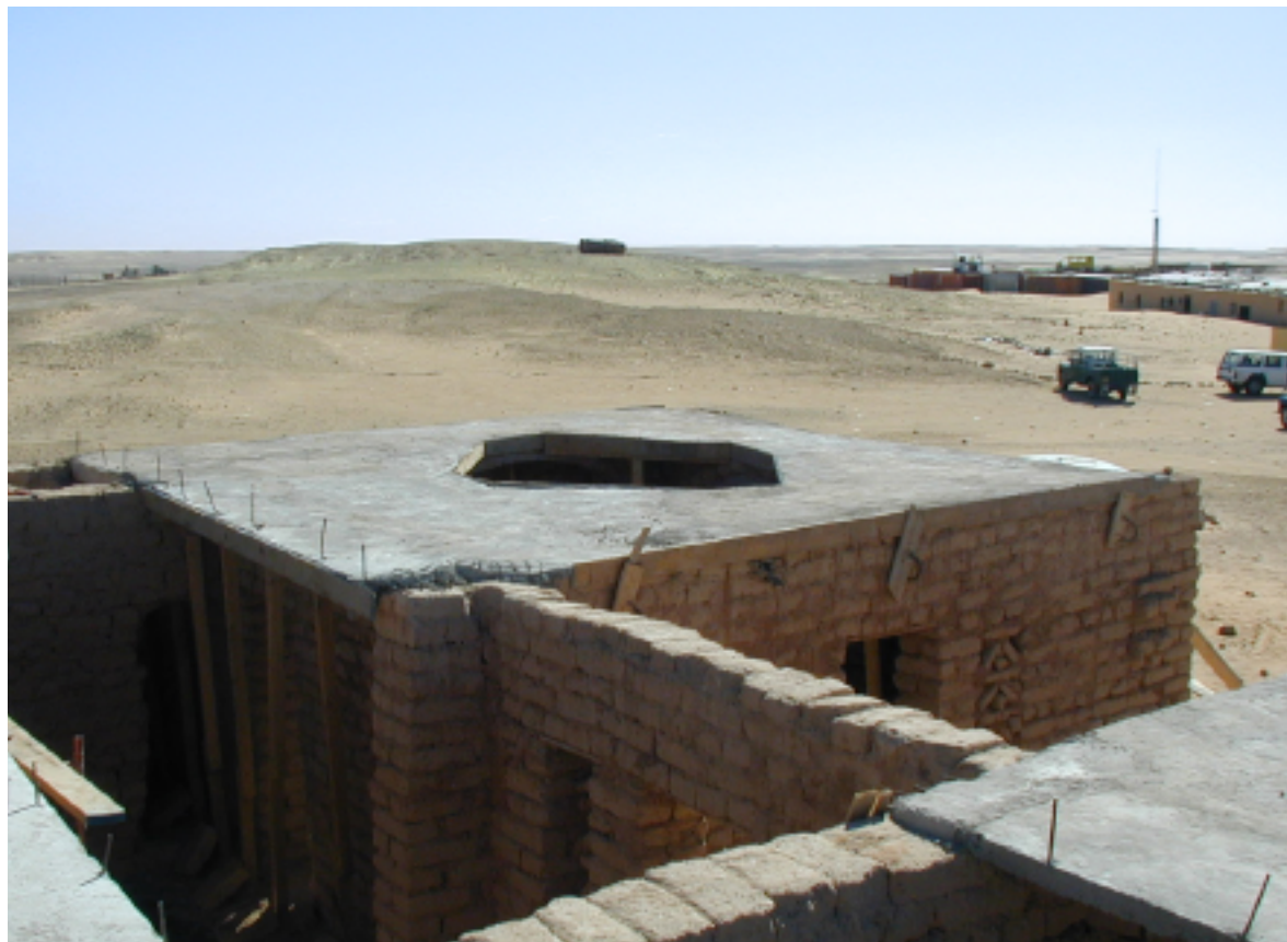
87. Il foro ottagonale d'imposta della cupola.
