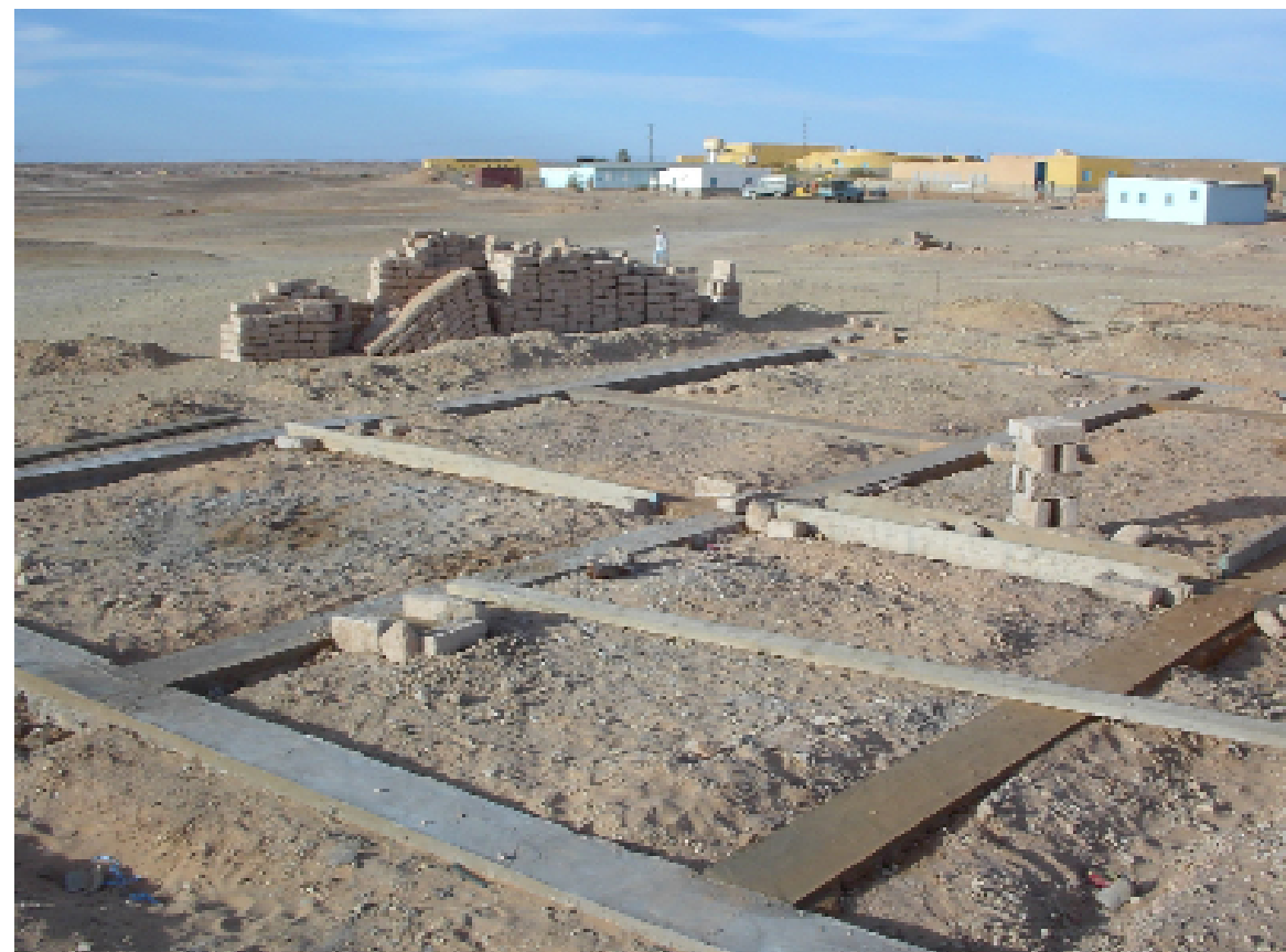
72. Le fondazioni completate assicurano una precisa orizzontalità del piano di posa delle murature.
