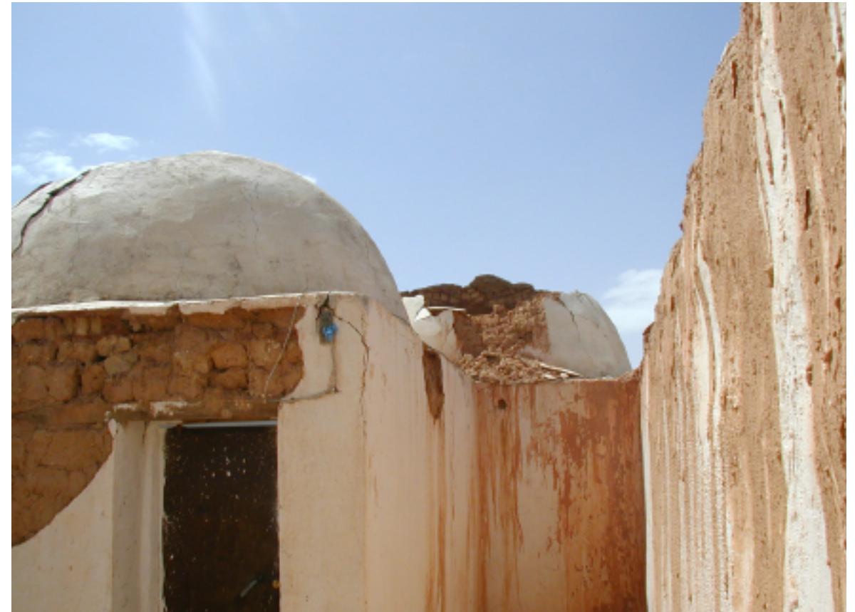
80. Danni alle cupole dei villaggi provocati dall'alluvione.
