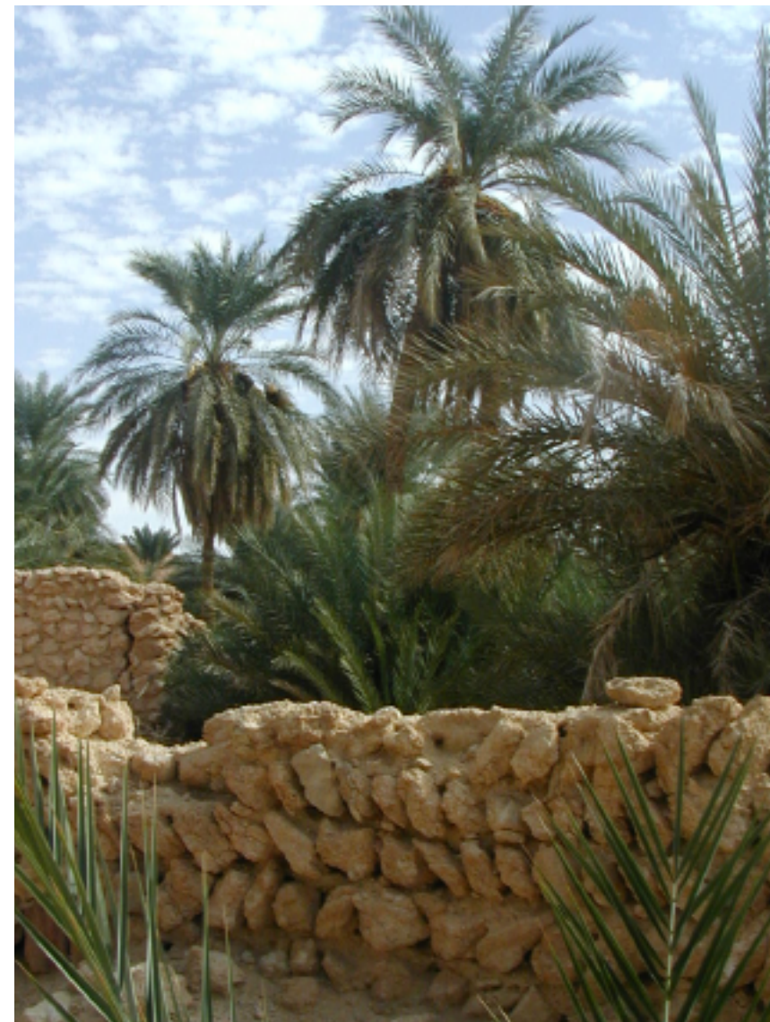
13. Di pietre, di terra o di frasche, il recinto raccoglie umidità in rapporto alla superficie esposta. I blocchi di terra non sigillati aumentano la capacità di raccolta.
