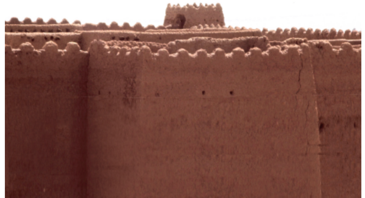
19. Costruzioni merlate in terra cruda a Timimoun, Algeria.
