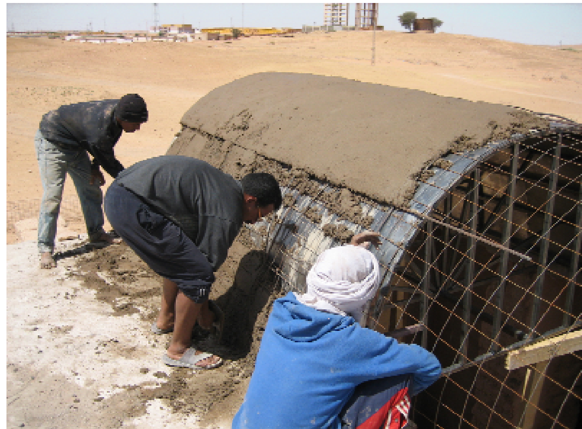
90. Armatura e manto di copertura in malta di cemento.
