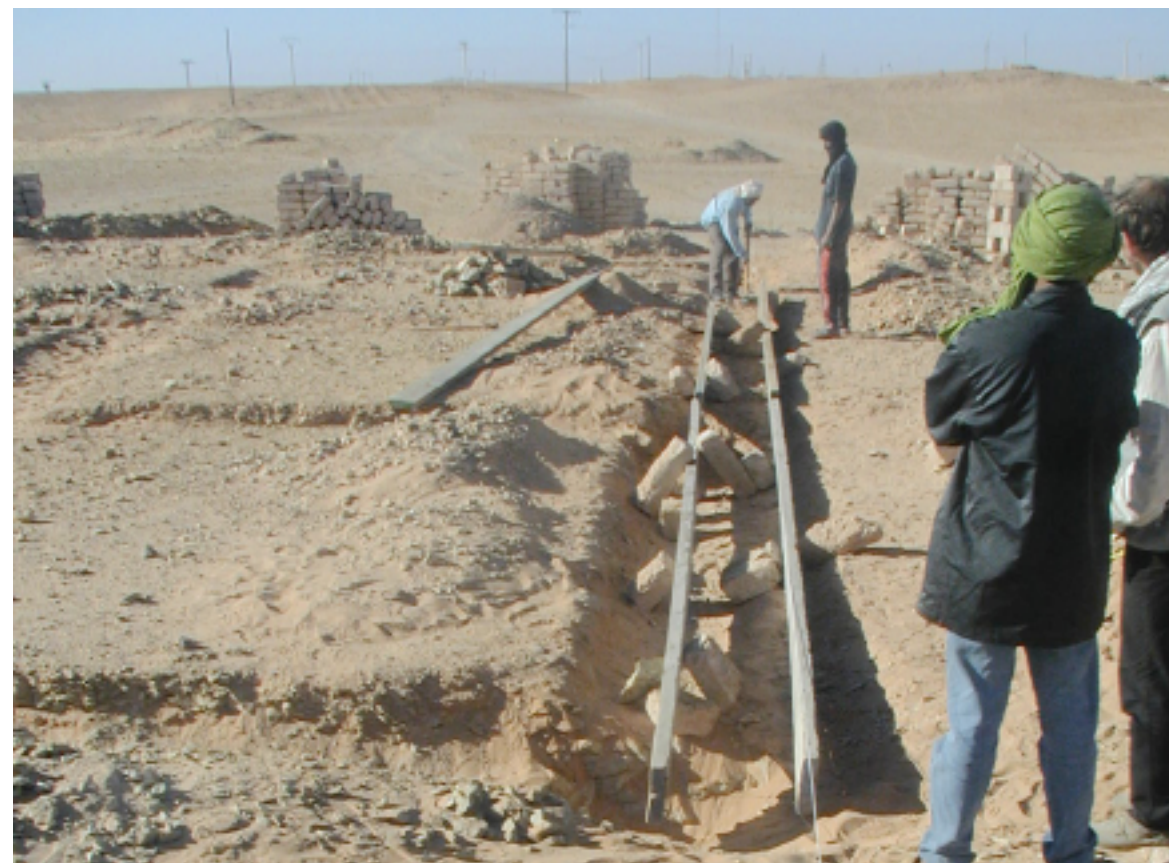
70. Tavole di contenimento delle fondazioni in sassi e cemento. Si notano in basso i fili guida orizzontali.
