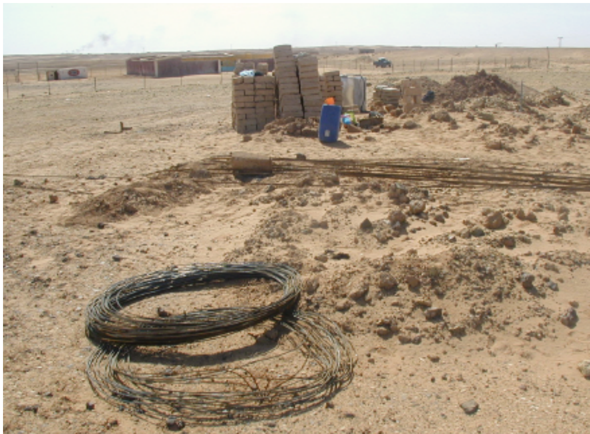
67. Materiali di cantiere. Dietro ai mattoni accatastati si intravede il contenitore di lamiera zincata per l'acqua di cantiere.
