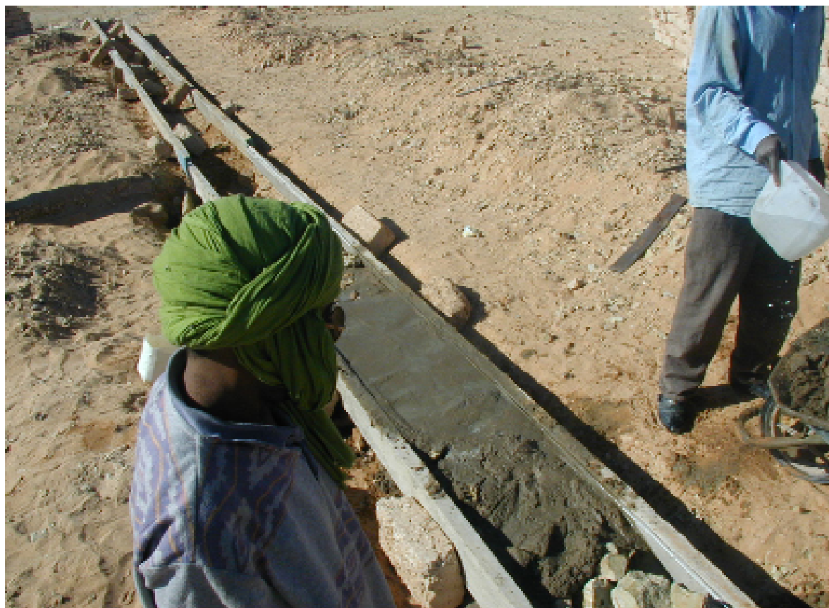
71. Realizzazione del sistema di fondazioni per la muratura del fabbricato tutta portante, sia esterna che interna.
