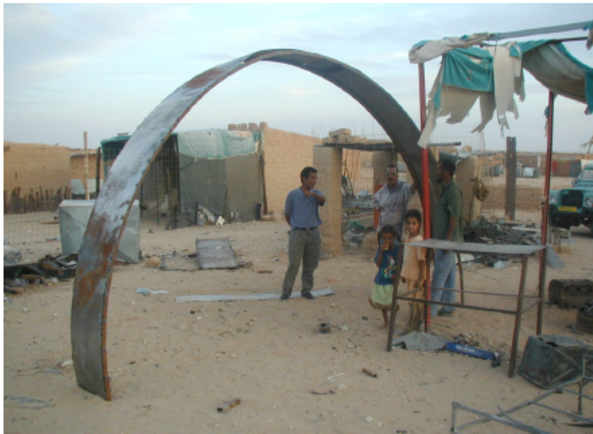
73. Centina metallica per gli archi strutturali, diametro 5 metri. Ne saranno realizzate 4 per poter lavorare su più ambienti contemporaneamente. In realtà gli archi erano previsti in mattoni di terra, ma la consistenza del materiale non ha dato sufficienti garanzie per il sostegno della cupola, per cui si è optato per la soluzione ibrida terra cruda - cemento, della cui tecnologia il costruttore aveva buona esperienza.
