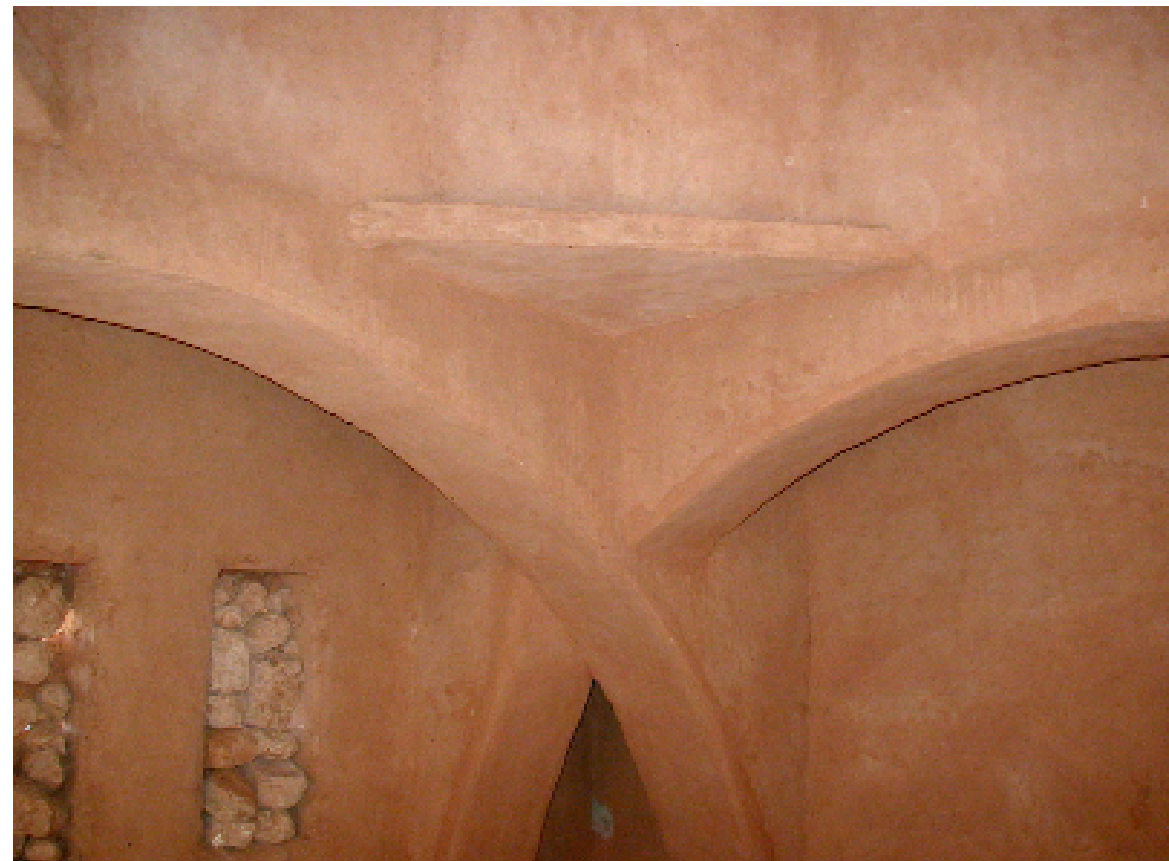
77. Gli archi finiti con intonaco in terra cruda mista a un collante naturale.
