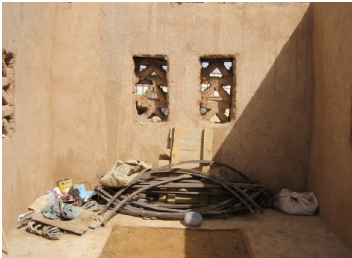
85. A seguito dell'evento calamitoso, si è ritenuto opportuno modificare il programma dei lavori con una differente tecnologia di realizzazione delle coperture. Nella foto gli elementi smontati che costituiscono la centina di sostegno della cupola in c.a.
