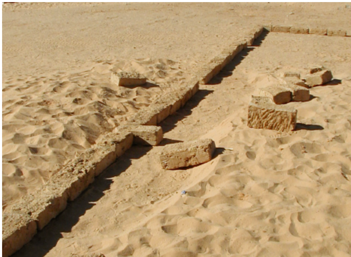
24. Nella costruzioni Saharawi non si prevedono fondazioni, ma le murature sono elevate direttamente sul terreno, semplicemente sgombrato dalla sabbia superficiale.
