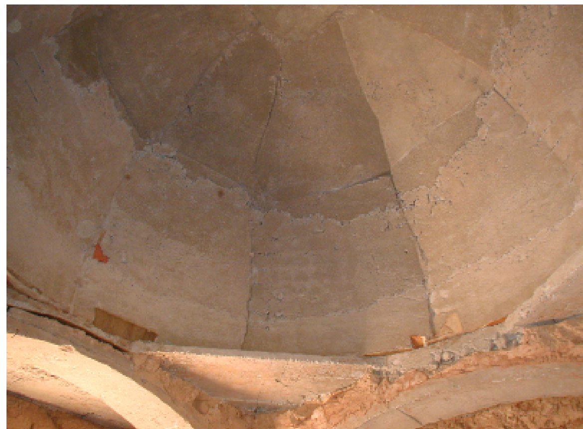
86. L'intradosso della cupola con geometria irregolare dovuta ai rudimentali elementi di carpenteria impiegati.
