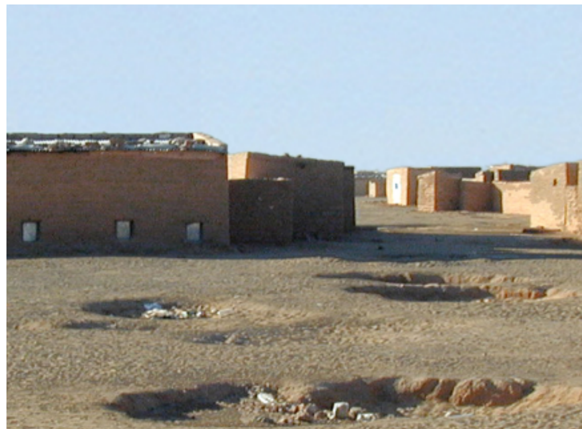
27. Le grandi buche davanti alle case sono il luogo di prelievo della terra per realizzare i mattoni.
