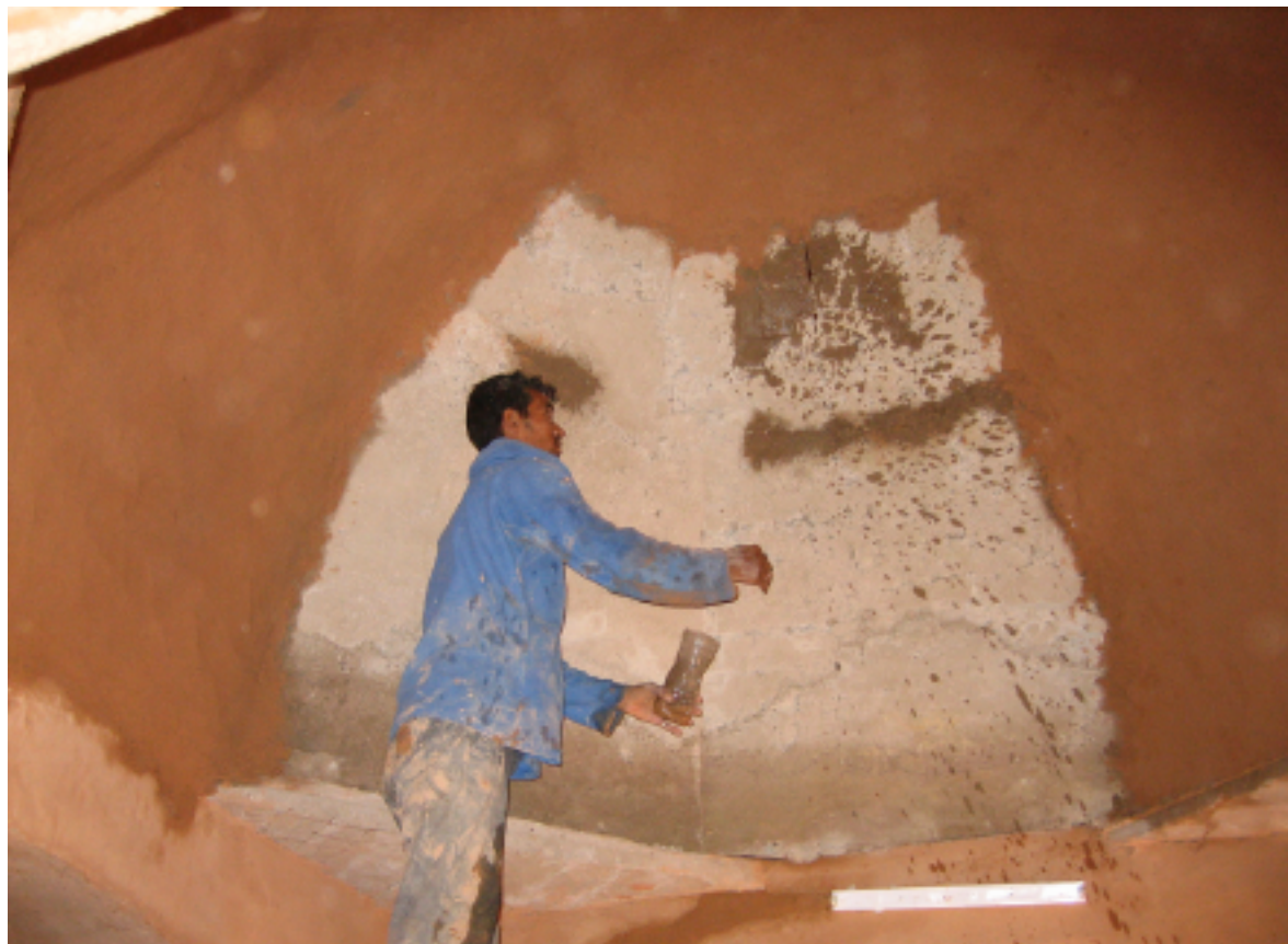
93. Intonaco con impasto di terra e acqua, additivato con collante naturale, steso a mano all'intradosso della cupola.
