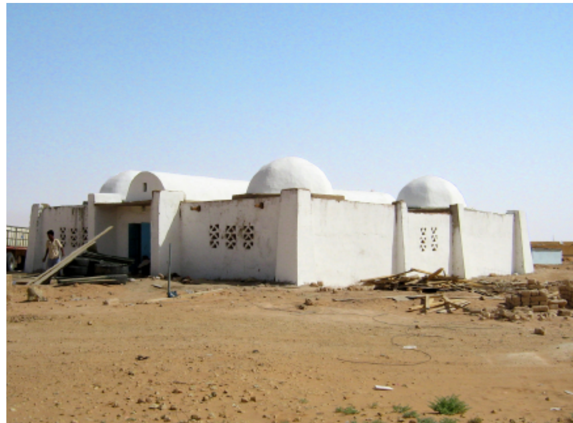
98. Tutto il fabbricato è stato trattato con latte di calce impermeabilizzante.
