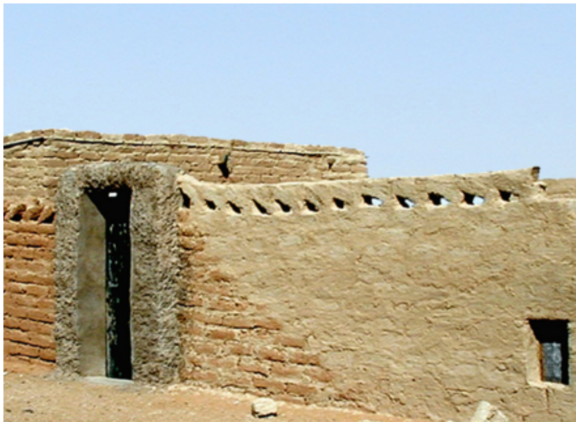
26. Muratura e coronamento con semplice decorazione in parte intonacati.
