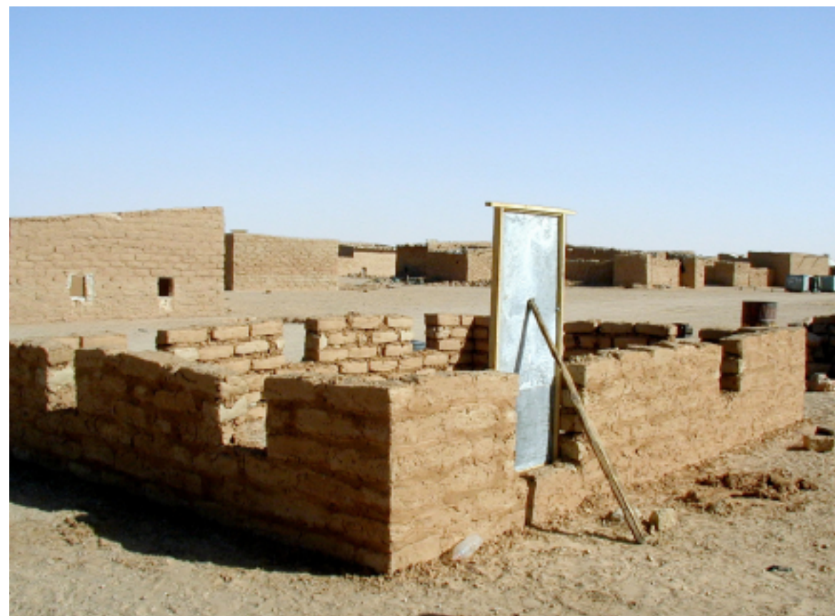
25. Costruzione di una casa Saharawi. Lo spessore dei muri è a una testa, cioè 20 cm.
