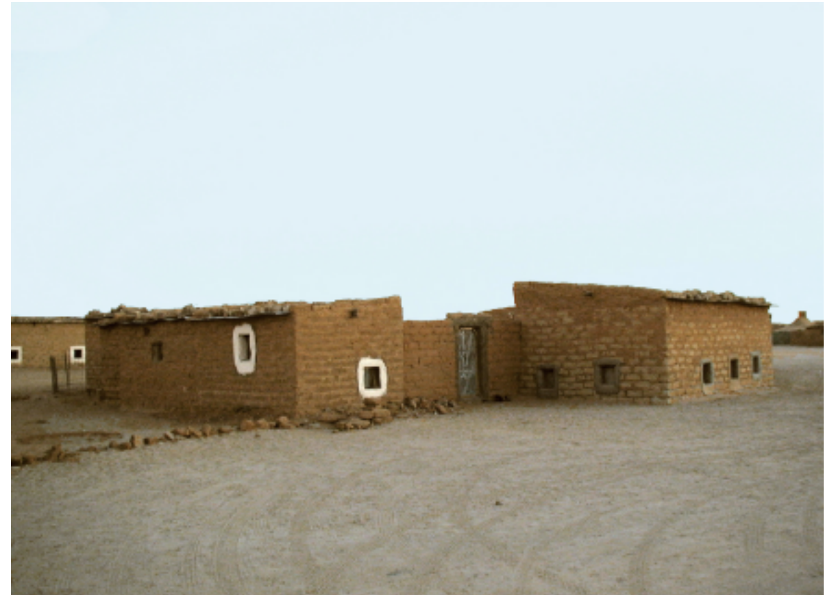
30. Le piccole finestre, incorniciate di calce, riducono l'irraggiamento solare, ma assicurano buona illuminazione. Il posizionamento in basso è per fare affluire aria dove le persone sostano, sedute a terra o sdraiate. Le finestre alte sono poste in corrispondenza della cucina e del deposito, dove le persone lavorano in piedi.
