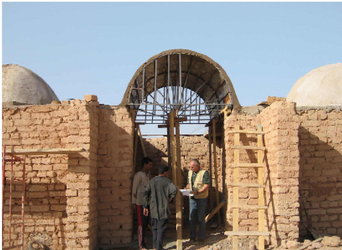
91. Il primo tratto della volta è realizzato.
