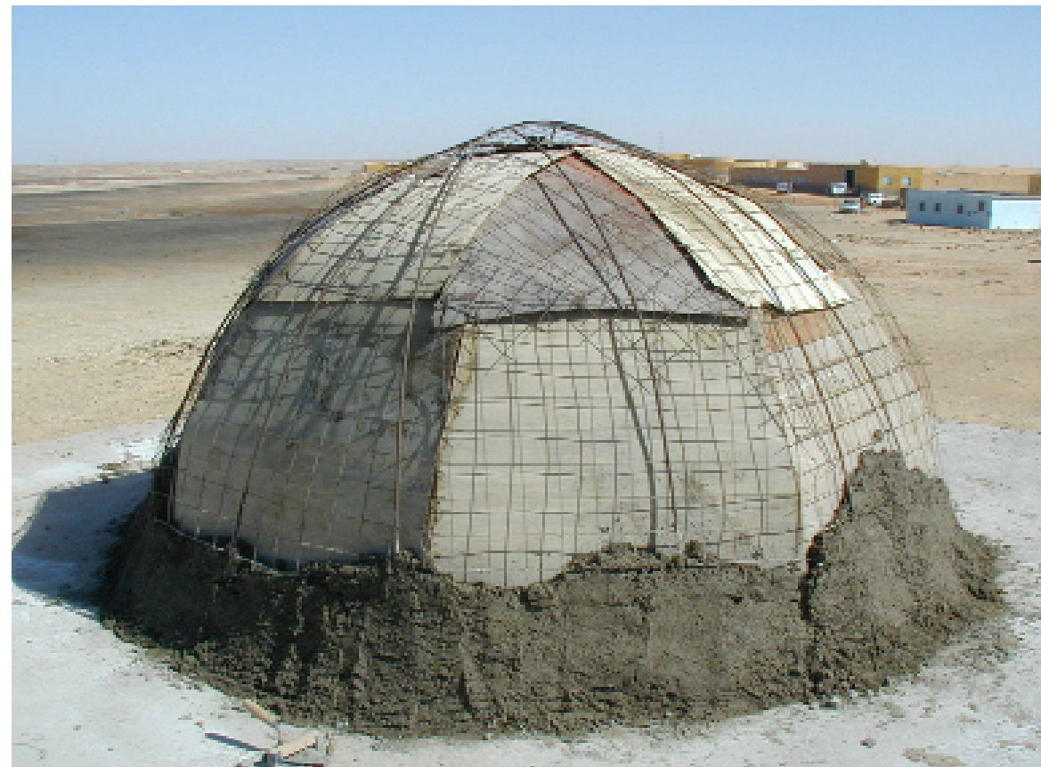
88. Armatura in tondini di acciaio disposti a meridiani e rete elettrosaldata approssimativamente sagomata in forma "semisferica" su una carpenteria di elementi in legno compensato accostati. La malta di cemento viene applicata a rinzaffo.
