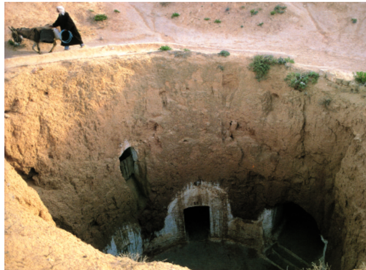
3. Matmata, Tunisia: insediamento ipogeo. L'ambiente al piano superiore è un deposito di derrate, talvolta alimentato direttamente dall'alto per evitare la discesa di muli o cammelli attraverso lo stretto cunicolo d'ingresso.
