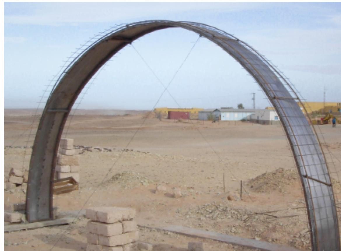
73. Una centina posizionata e provvista di armatura per la soletta in c.a.
