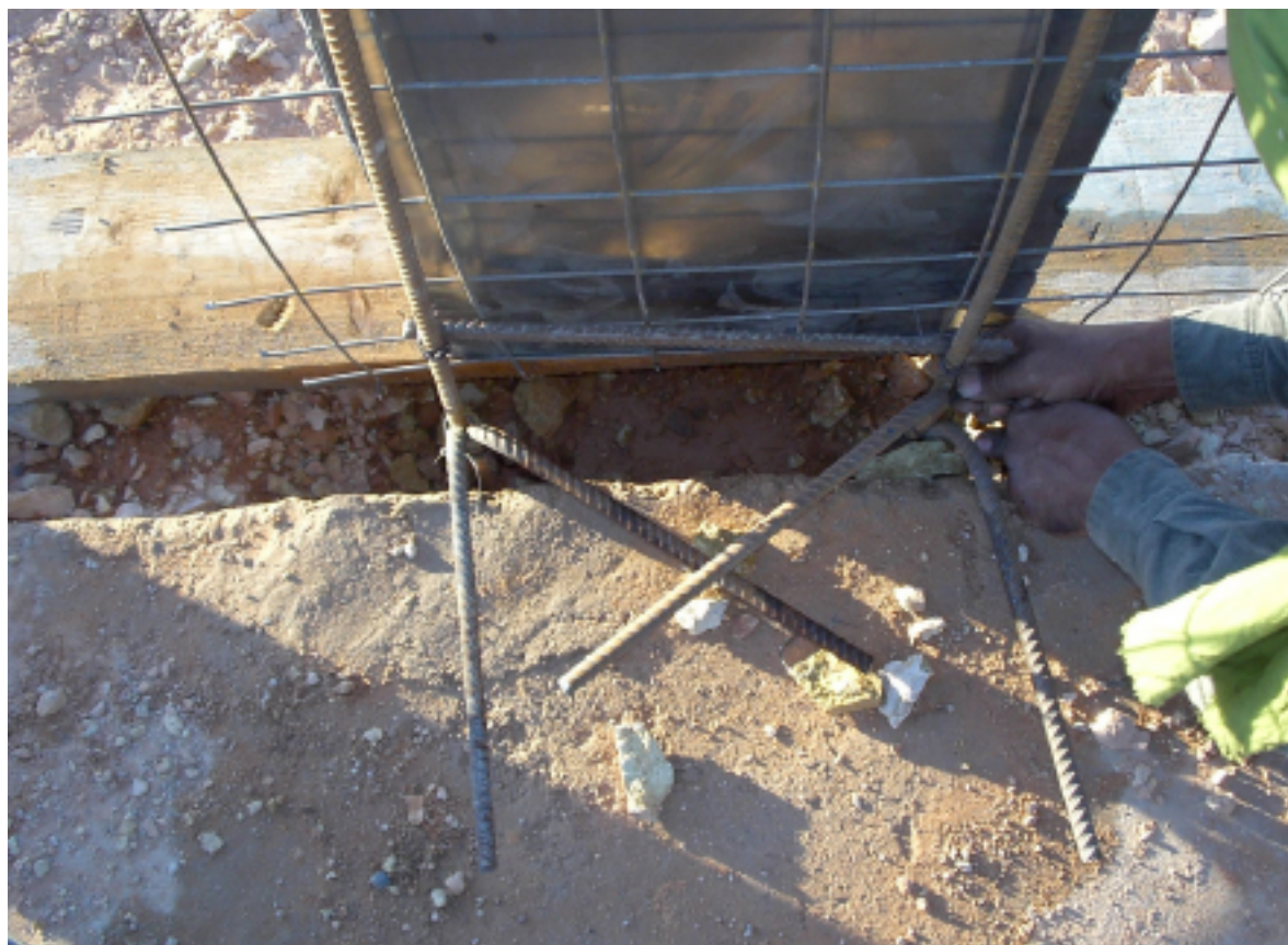
74. Armatura dell'attacco a terra dell'arco.
