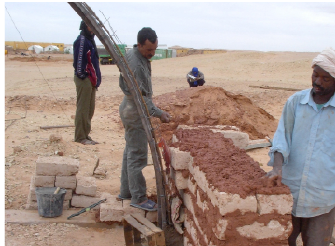
75. Si comincia a realizzare il muro perimetrale per contrastare le sollecitazioni che verranno dall'arco caricato.
