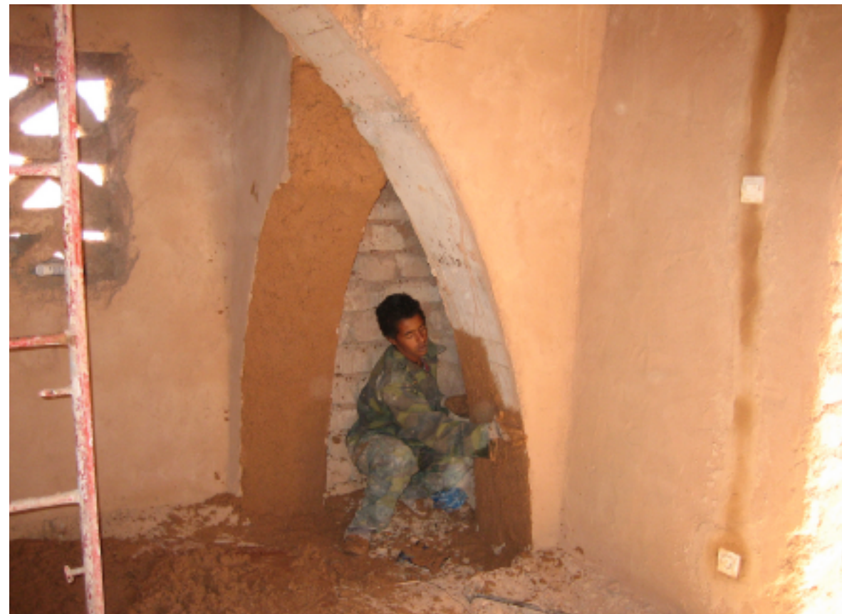
94. Intonaco a mano sugli archi strutturali.
