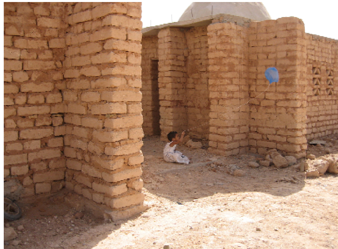
102. Ingresso non vietato ai non addetti ai lavori.
