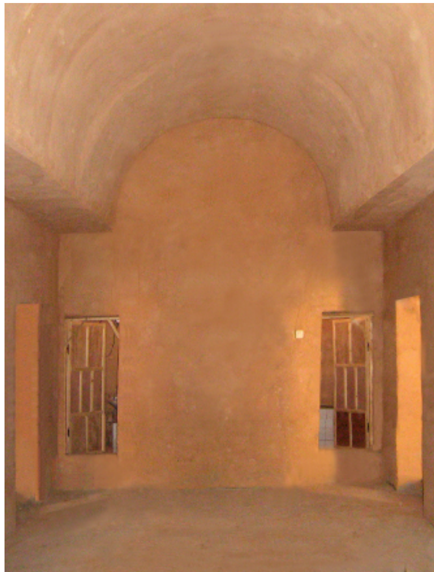
59. La Casa de la Mujer, corridoio centrale con copertura a volta.
