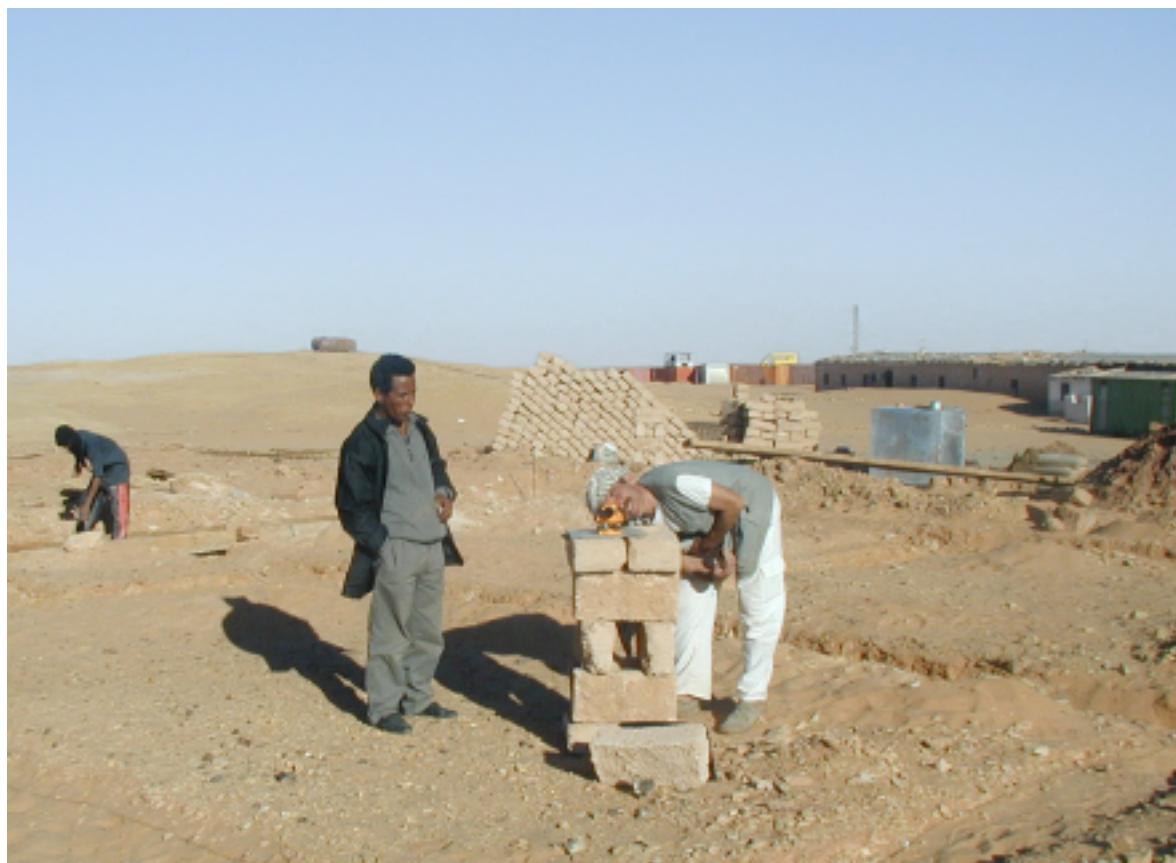
69. Mirco Monari controlla la messa a livello del filo delle fondazioni. Questa attenzione si rivelerà molto importante per la sua preservazione rispetto ai danni provocati dall'alluvione del marzo 2006, a cantiere in corso.
