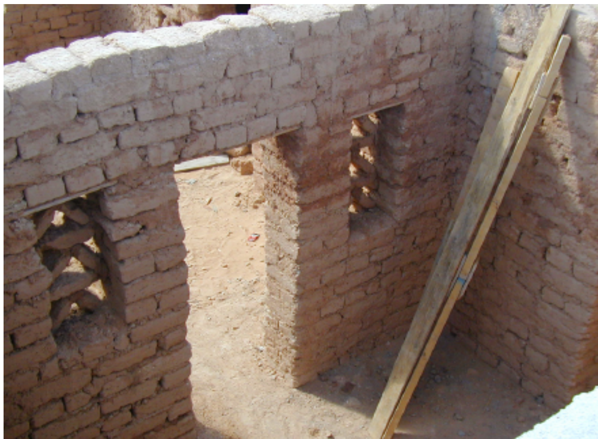
78. Muratura con finestre grigliate, al grezzo.
