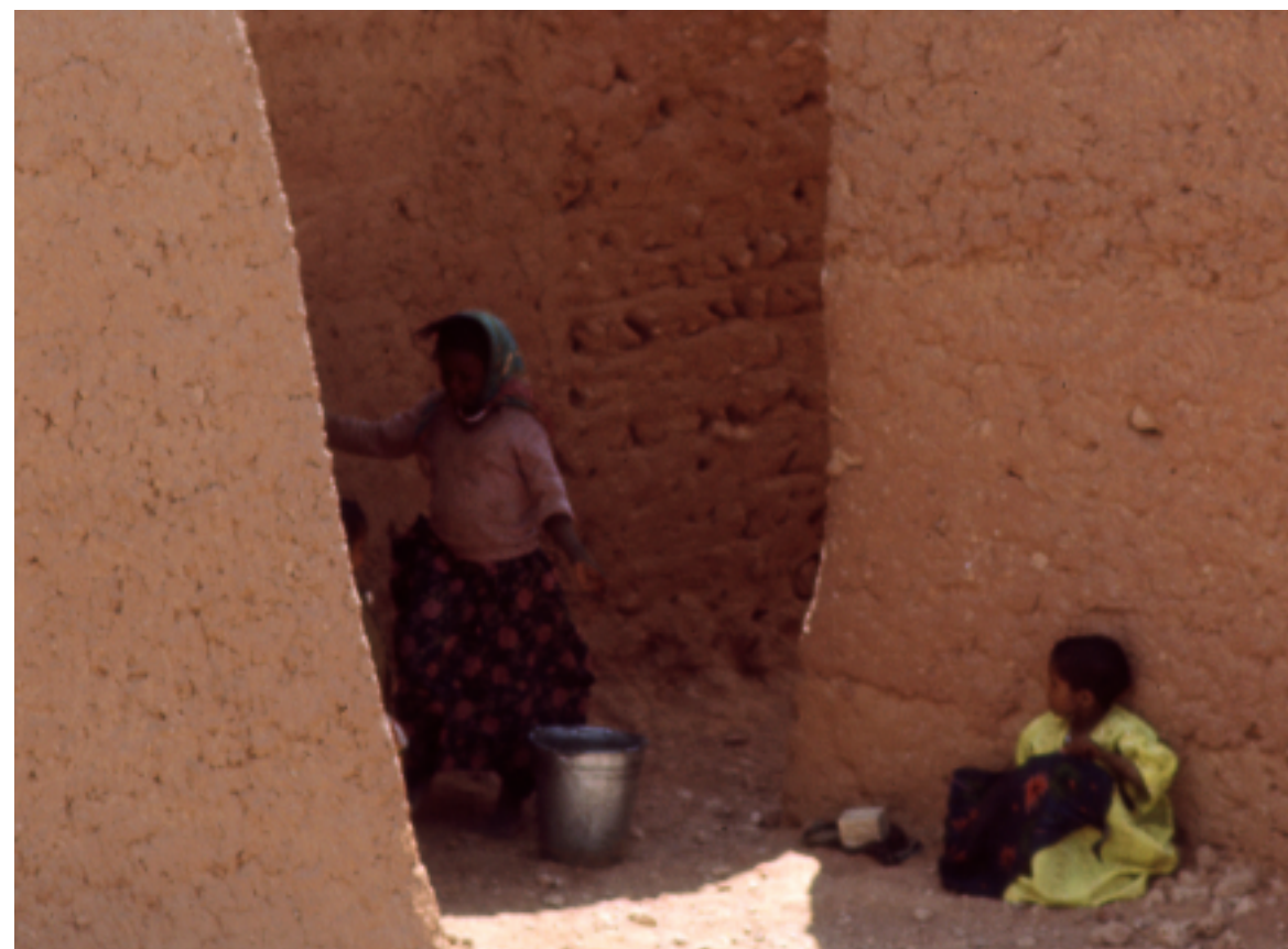
21. Muri di terra nei pressi di Timimoun, Algeria.
